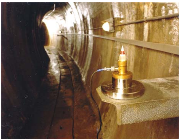
Figur 2.08-1: Winkelmessung in einem Kontrollgang
