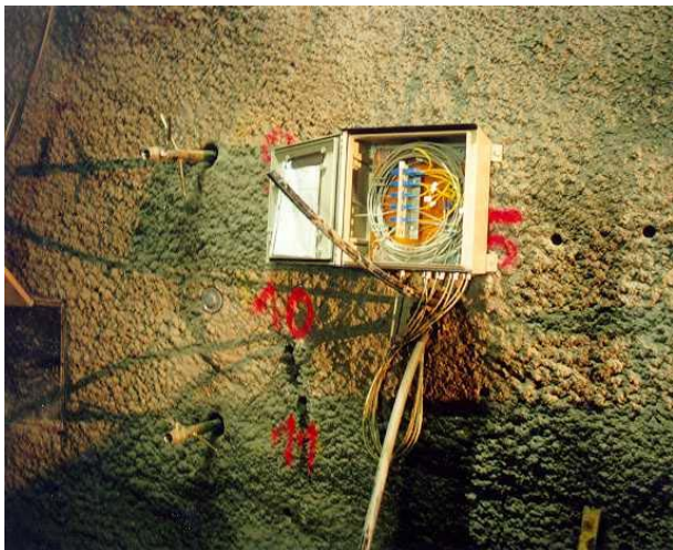
Figur 2.16-3: Einbau im Bohrloch: Nur die Verbindungskabel ragen aus dem Bohrloch und werden in einen Verteilkasten geführt
