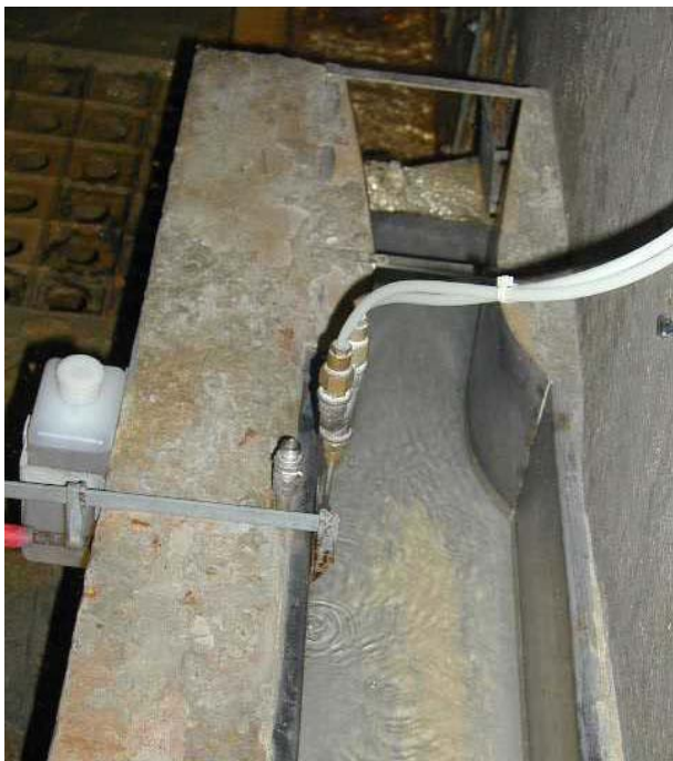
Figur 3.02-3: Messkanal mit Venturi und Niveaumessung mittels Lufteinperlung
