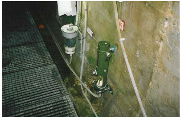
Figur 2.12-2: Schlauchwaage in einem Kontrollgang im Fundament einer Talsperre
