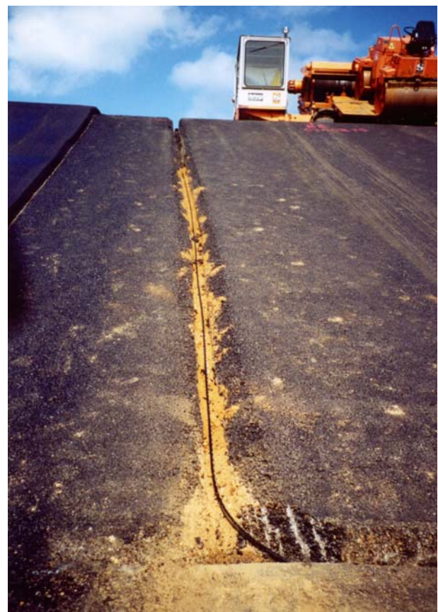
Figur 1.15-2: Einbau eines Messkabels unter der bituminösen Deckschicht eines Damms (Quelle: GESO, LTV des Freistaates Sachsen)
