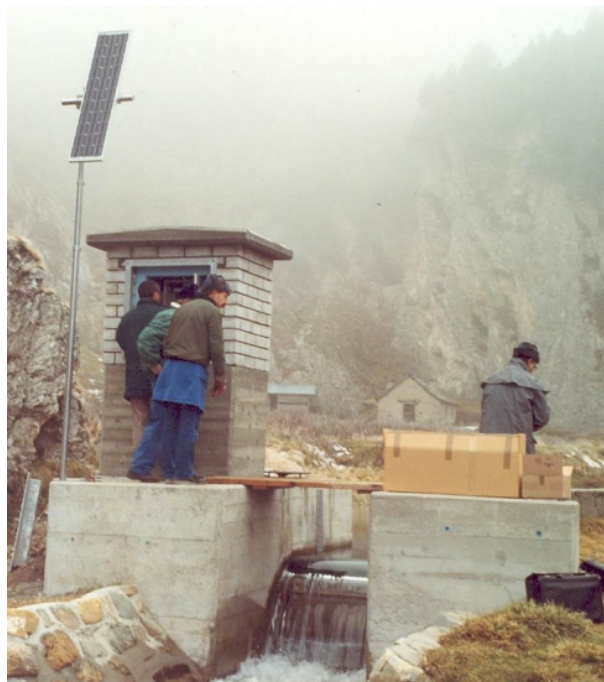
Figur 3.02-4: Messüberfall für grosse Abflüsse, automatische Abflussmessstation
