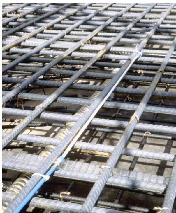
Figur 2.16-2: Einbau im Beton: Das Glasfaserkabel ist an Armierungseisen montiert
