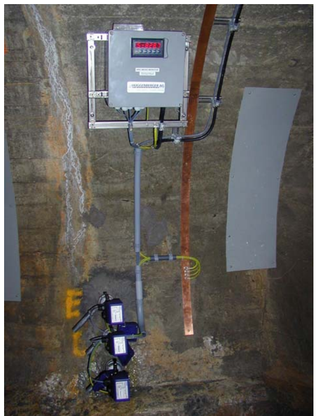
3.06-9 Geschlossenes System mit elektrischer Druckmesszelle, direkt am Bohrloch angeschlossen, mit Fernübertragung zur Vermeidung von Druckverlusten
