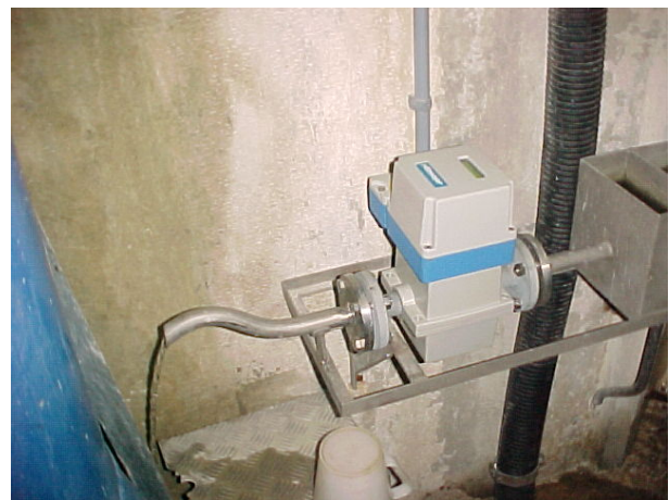
Figur 3.03-2: Durchflussmessgerät. Das Ablaufrohr ist nach oben gekrümmt, damit das Rohr immer voll durchfließen wird
