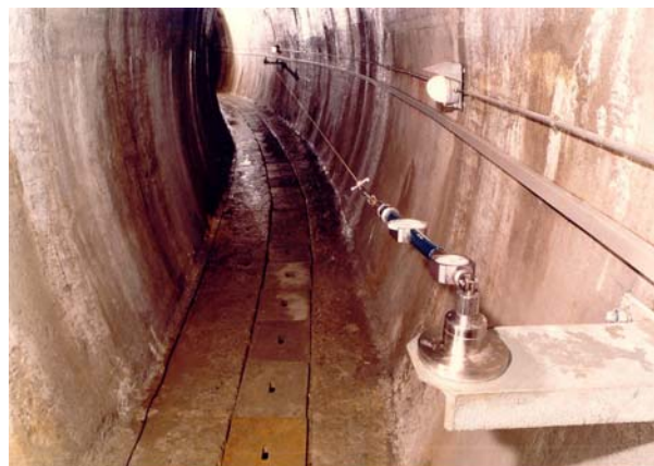
Figur 2.08-2: Distanzmessung mit Invardraht zwischen 2 Konsolen in einem Kontrollgang
