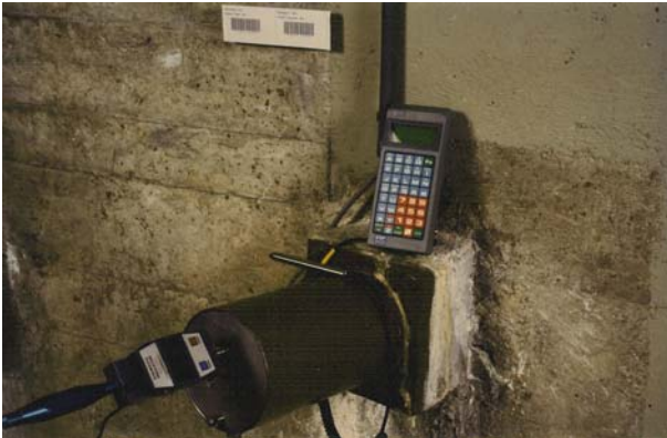
Figur 2.14-3: Messkopf mit Setzdeflektometer und Erfassungsgesät mit Messstellenidentifikation
