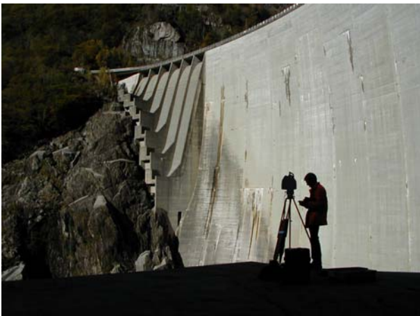
Figur 2.04-1: Mit Laser-Scanning können Staumaueroberflächen aufgenommen und z.B. Schäden kartiert werden
