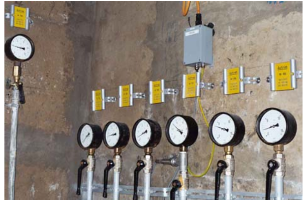
Figur 3.06-8: Geschlossenes System mit Manometern. Die dritte Messstelle von rechts wird über eine Druckmesssonde fernübertragen
