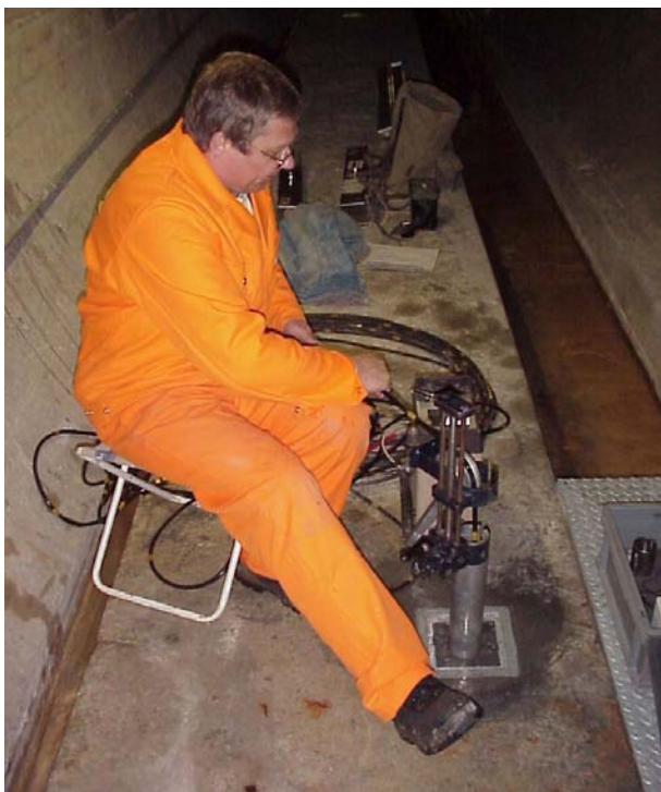
Figur 2.17-3: Ausführung einer Bohrlochmikrometermessung mit berührungsloser Induktionssonde
