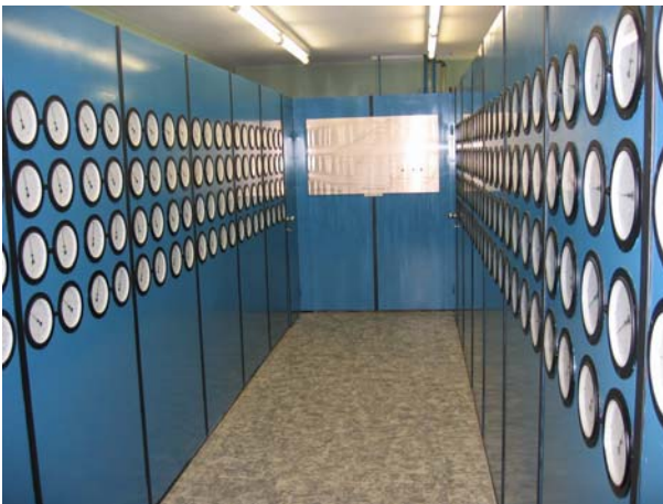
Figur 3.10-2: Messkammer für hydraulische Piezometer
