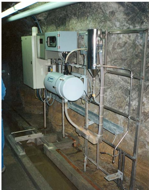
Figur 3.11-1: automatische Trübungsmessung, kombiniert mit automatischer Sickerwassermessung
