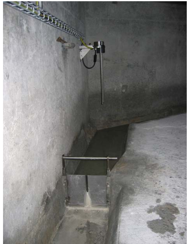
Figur 3.02-2: Messüberfall mit Echolotmessung
