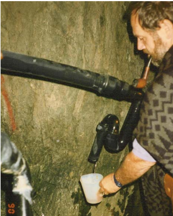
Figur 3.01-1: Volumetrische Sickerwassermessung mit Messbecher und Stoppuhr
